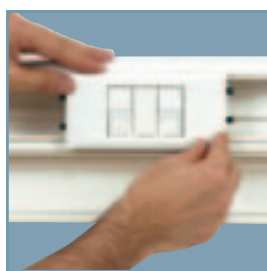
6 Soporte instalado en ducto.
